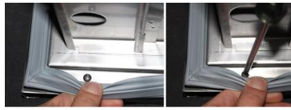
Schritt 3: Heben Sie nun den Ladenkasten samt Innenblende von der Außenblende ab und legen Sie den rosafärbigen Isolierstreifen zur Seite. Nachdem Sie die Niro-Klemmleiste von der Oberseite der Innenblende abgenommen haben, können Sie die alte Dichtung abziehen.
